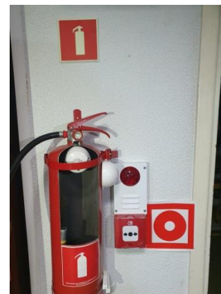
Рисунок. Огнетушитель в разрезе, с концепт решениями
